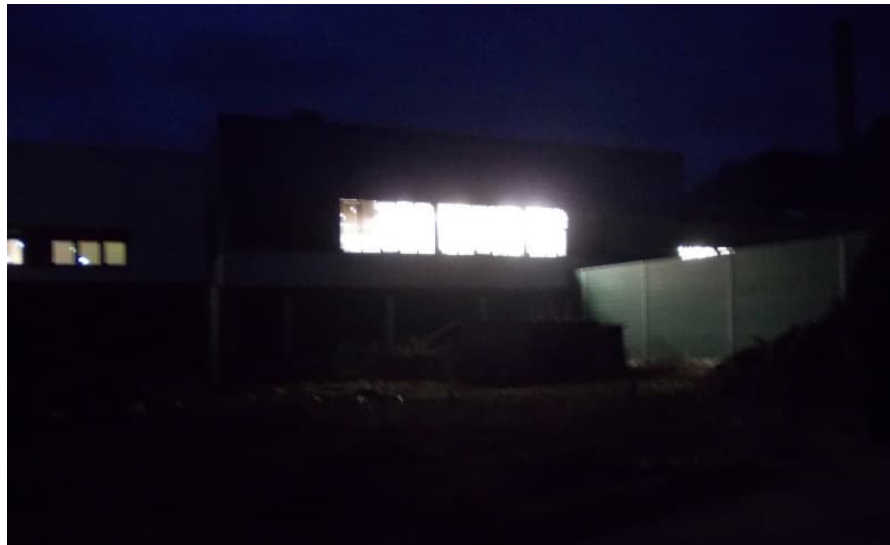
[Abteilung Umwelt-, Bau- und Anlagentechnik im Zuge eines LA]
