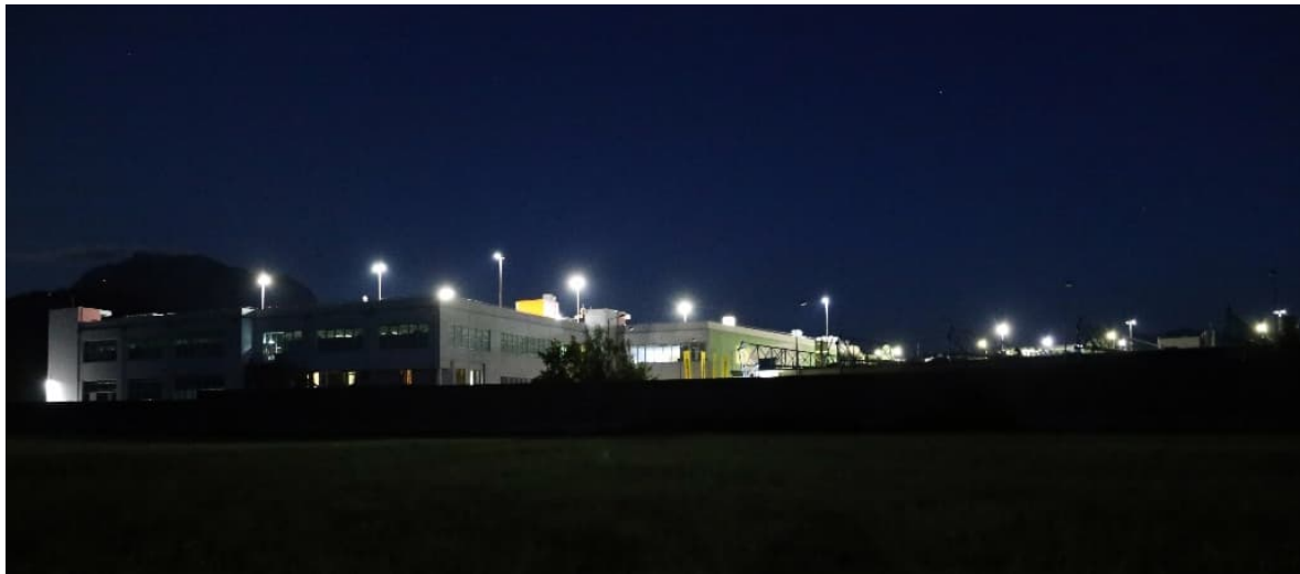
[Abteilung Umwelt-, Bau- und Anlagentechnik im Zuge eines LA]
