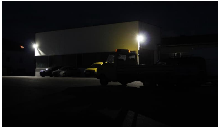
[Abteilung Umwelt-, Bau- und Anlagentechnik im Zuge eines LA]
