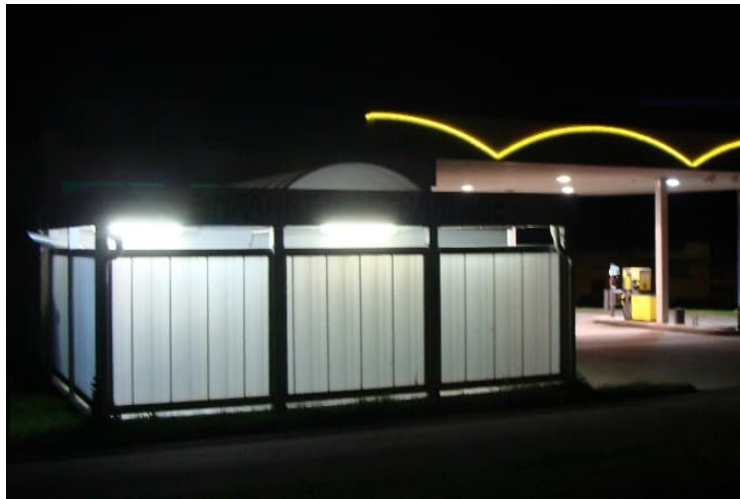
[Abteilung Umwelt-, Bau- und Anlagentechnik im Zuge eines LA]
